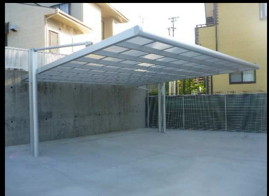
カーポート 土間コンクリート フェンス
